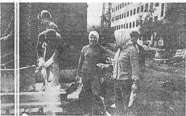
НА СНИМКЕ: будни стройки. Фото Л. Исакова.
