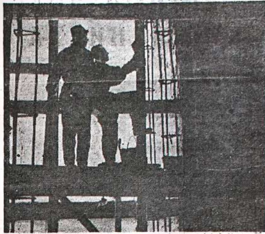
СТУДЕНТЫ НА СТРОИТЕЛЬСТВЕ НОВОГО УЧЕБНОГО КОРПУСА.
